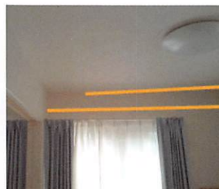
漏水検査(可視画像)
