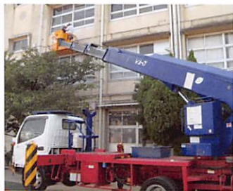
外壁打診調査(高所作業車)
