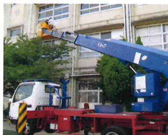
外壁打診調査(高所作業車)
